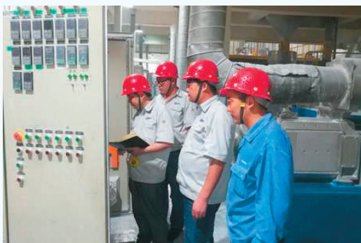
电气安全检查
